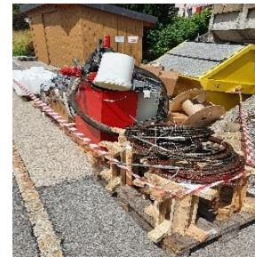
Material von Liftsanierung
